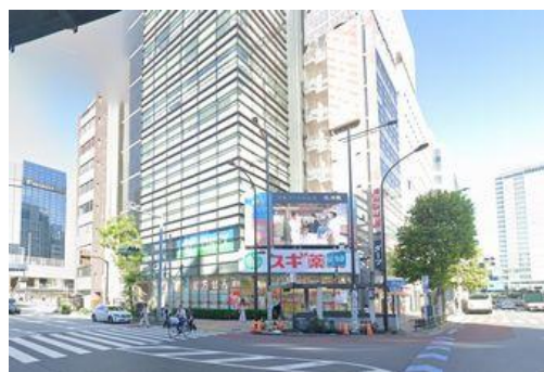
新橋駅前 AP新橋の入るビル
