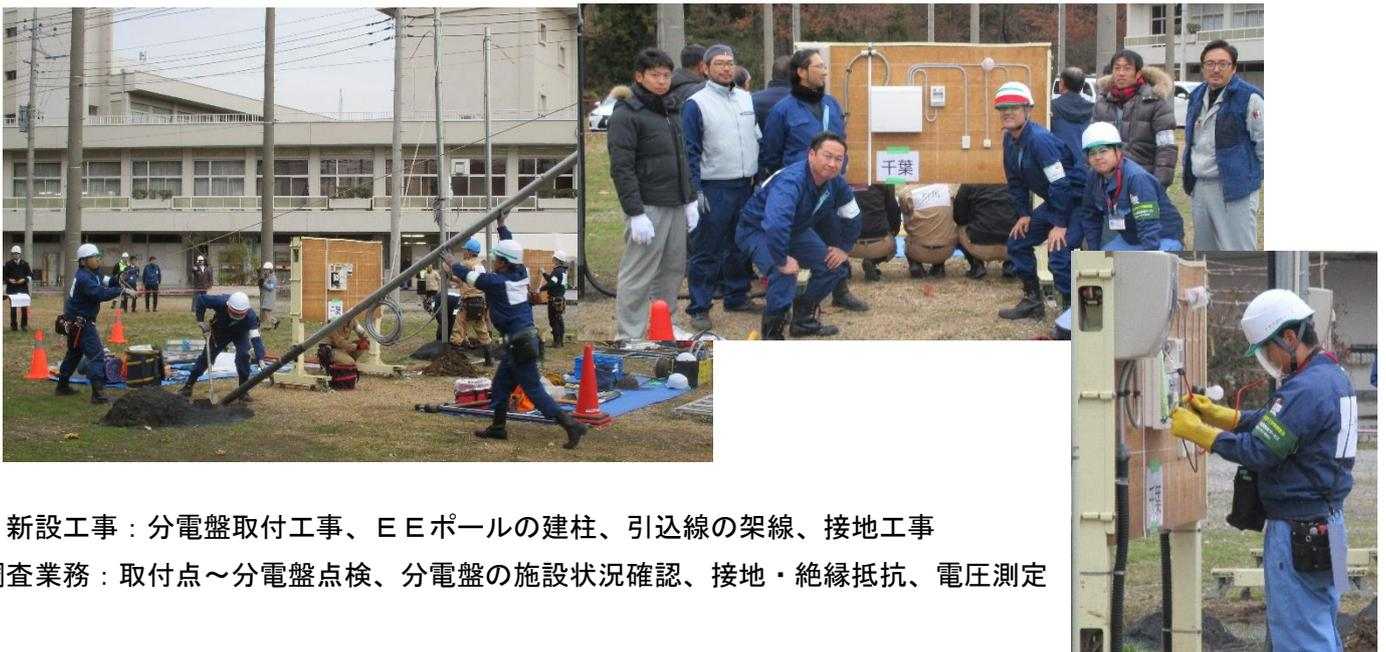
新設工事：分電盤取付工事、EEポールの建柱、引込線の架線、接地工事
