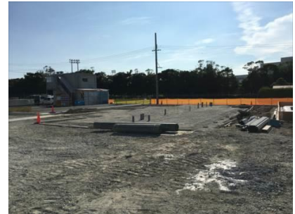
磐田市グループホーム建設予定地
