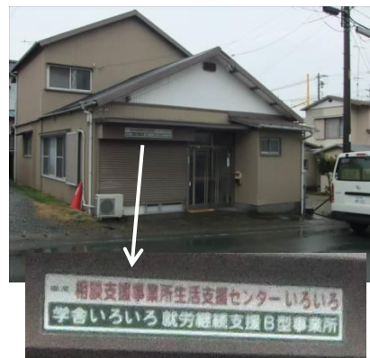
生活支援センターいろいろ (平成 20 年)
