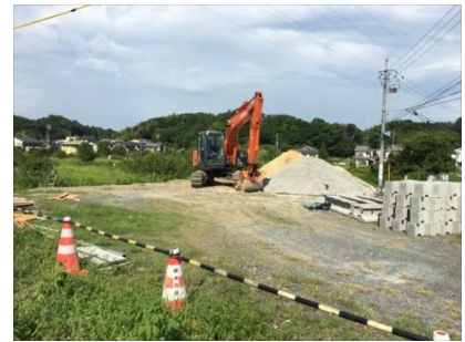
袋井グループホーム建設予定地
